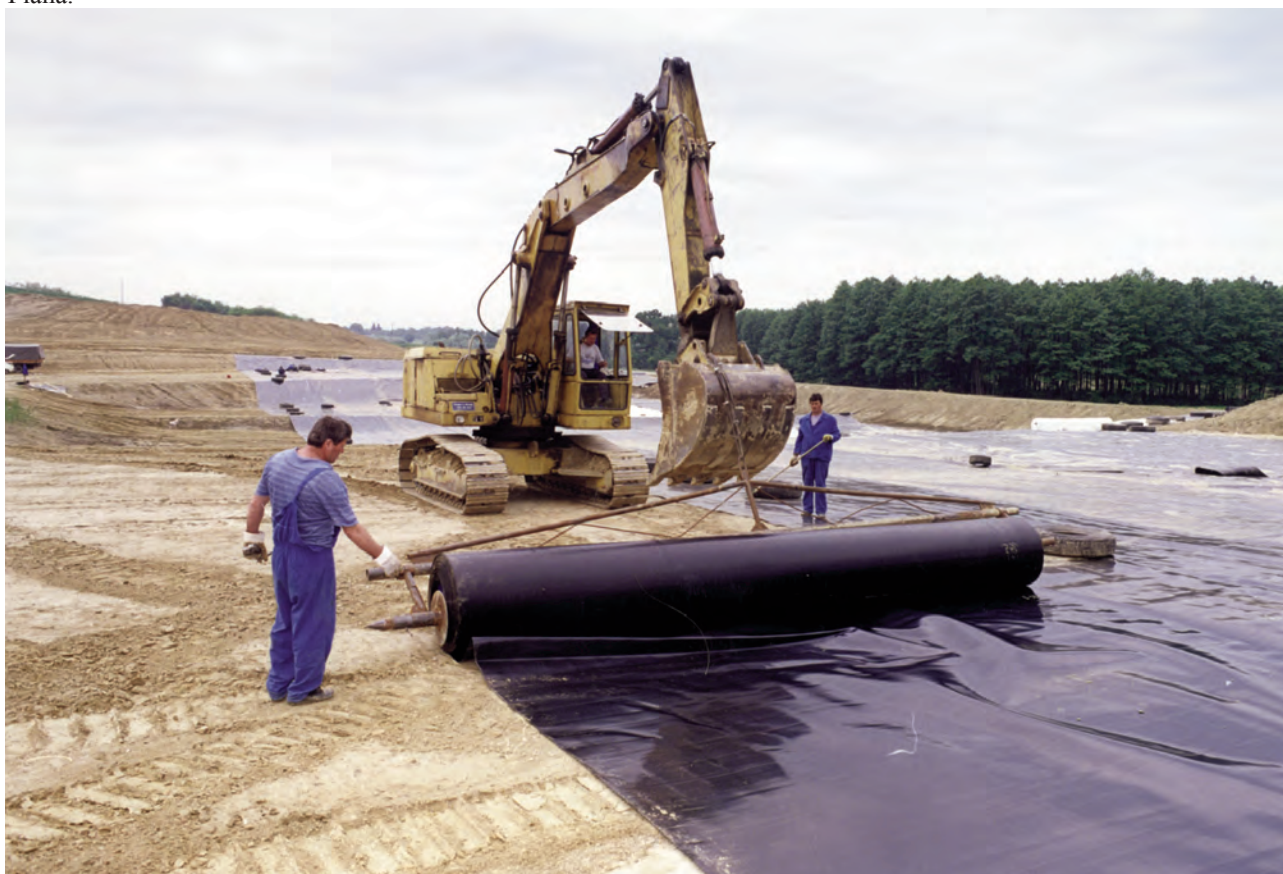
Izgradnja moderne deponije otpada.
